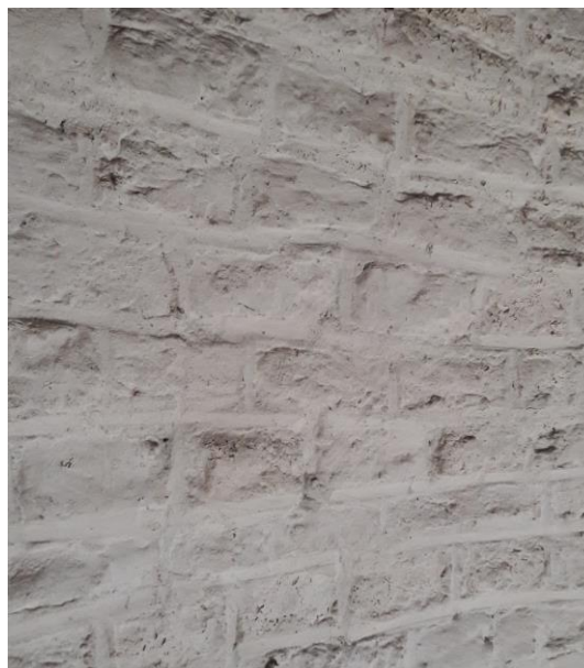
Afb. 14, Inwendige muurafwerking luizolder, oostzijde.
