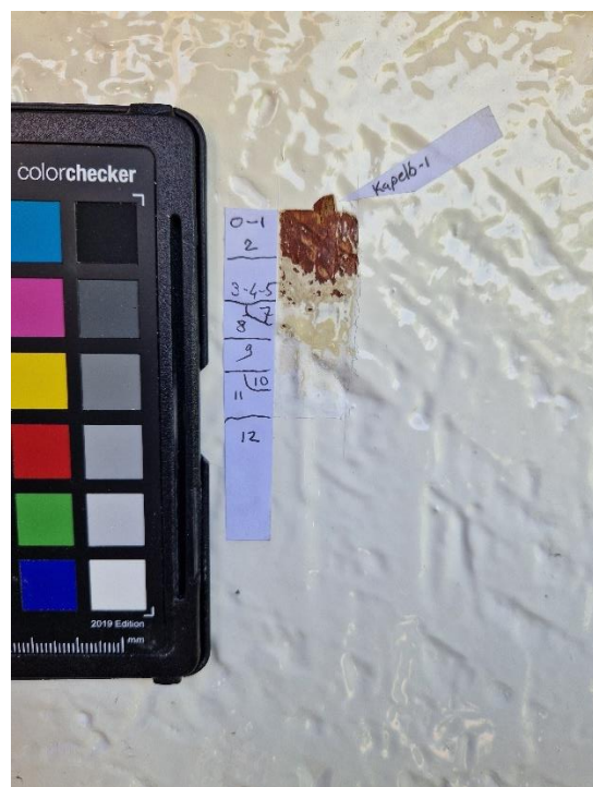
Figuur 43. Kleurtrap op een van de houten balken van het vakwerk van de noordgevel van de kapel. Locatie dwarsdoorsnede Kapelb1.
