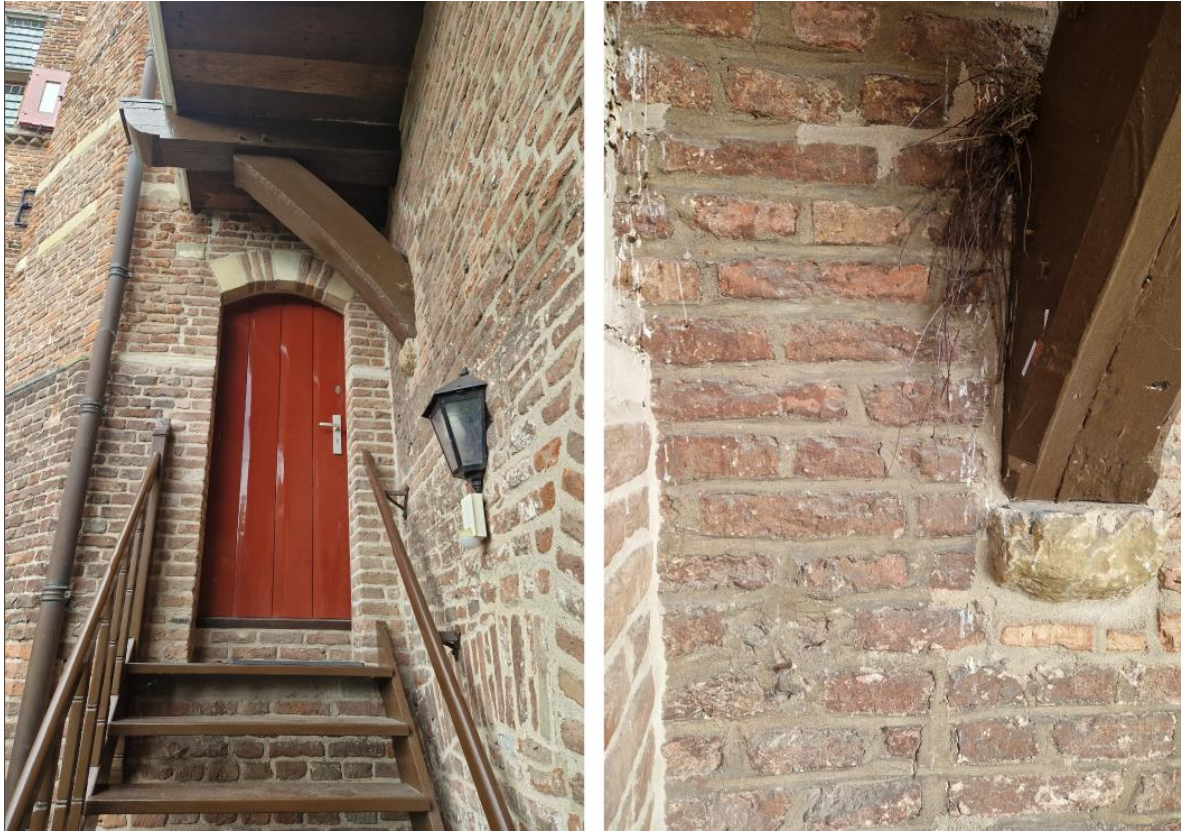
Figuur 38. Afdak onder de kapel, met in het zicht een rode deur en de balk onder de uithang van de kapel.
