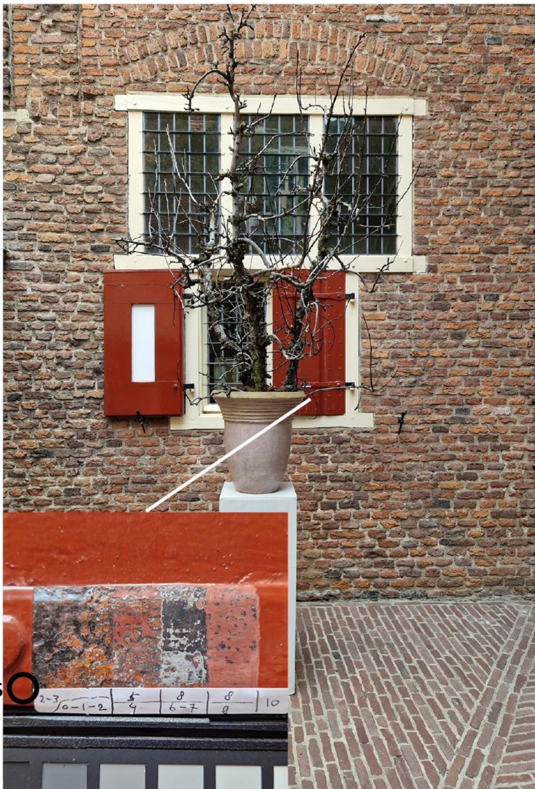
Figuur 27. Kleurtrap op het beslag van een van de luiken in het binnenplaats en de locatie van dwarsdoorsnede LH5.
