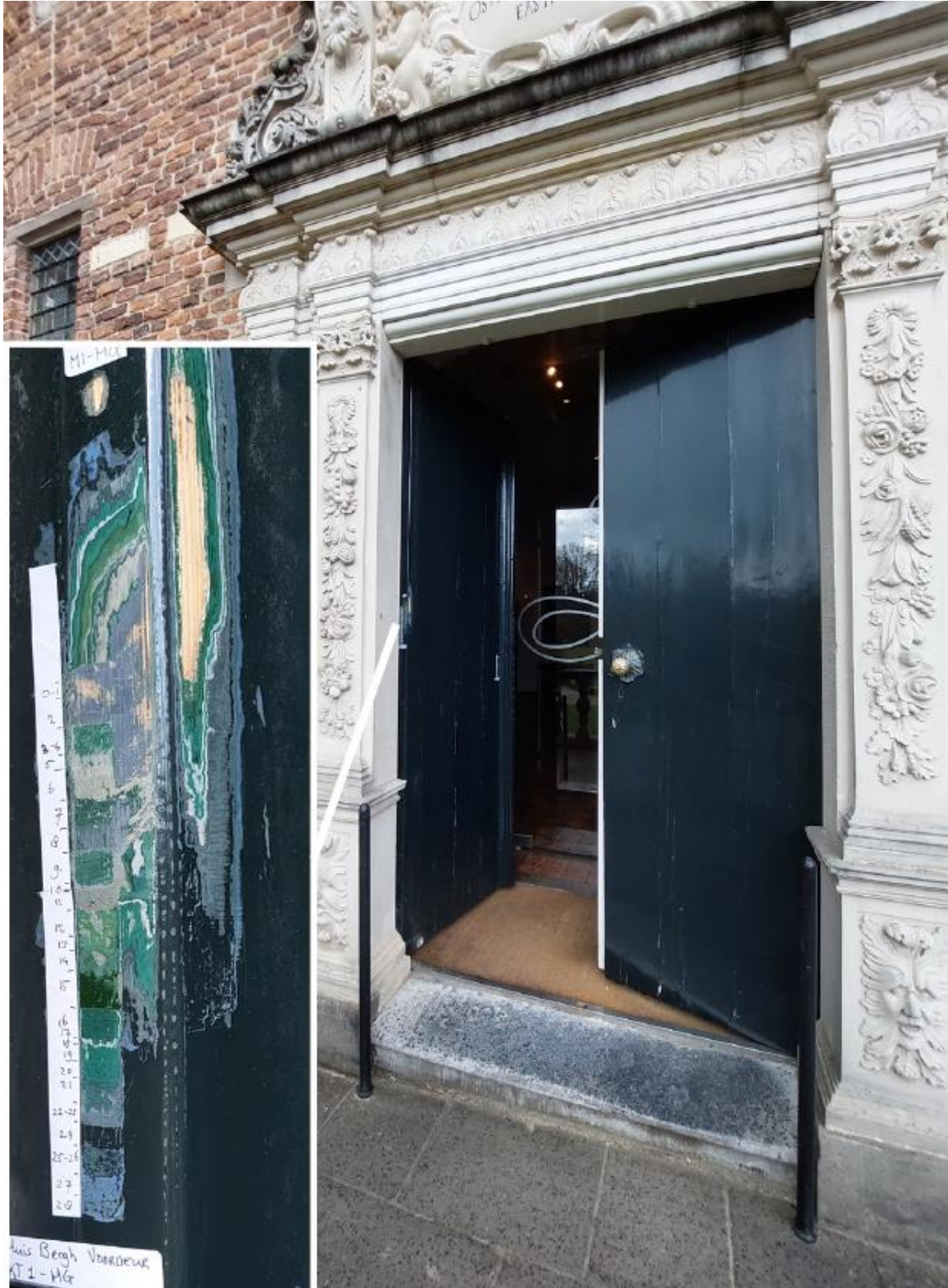
Figuur 59. Kleurtrap op de dagkant van de voordeur van het kasteel en locatie van de doorsnede, HG1. Zie hieronder.
