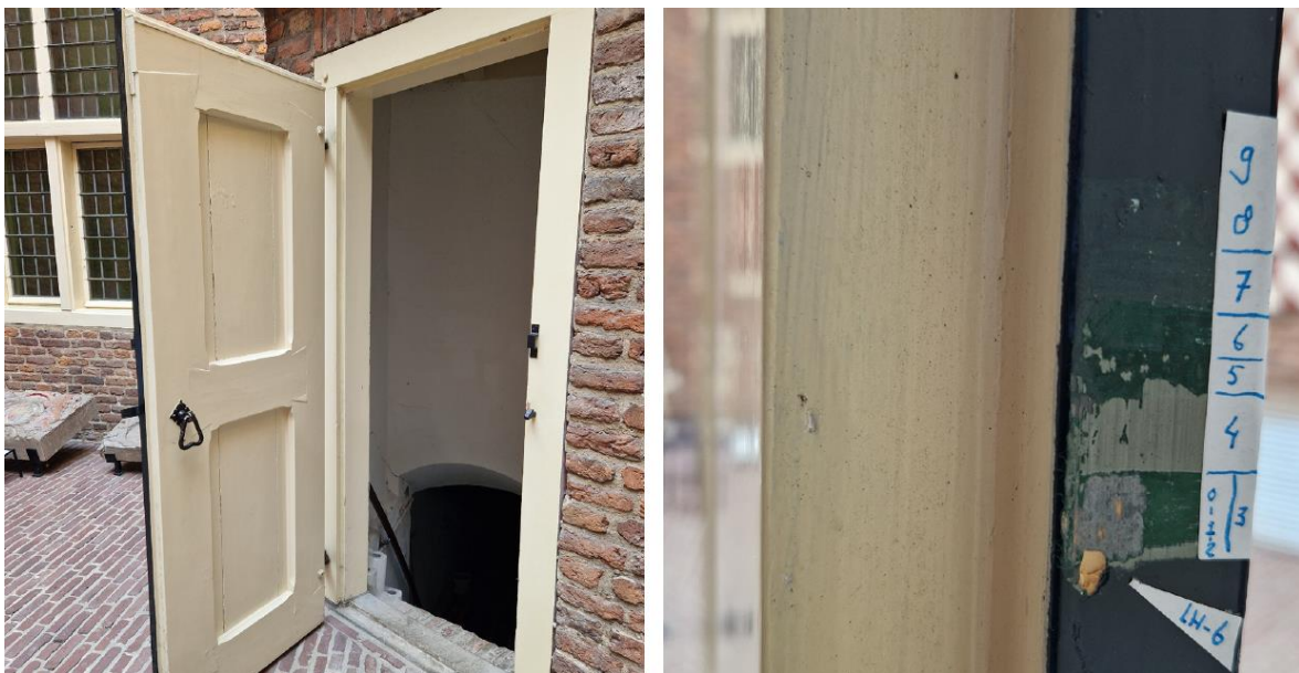
Figuur 31. Kleurtrap op een van de beschilderde deuren van het binnenplaats en de locatie van dwarsdoorsnede LH6.
