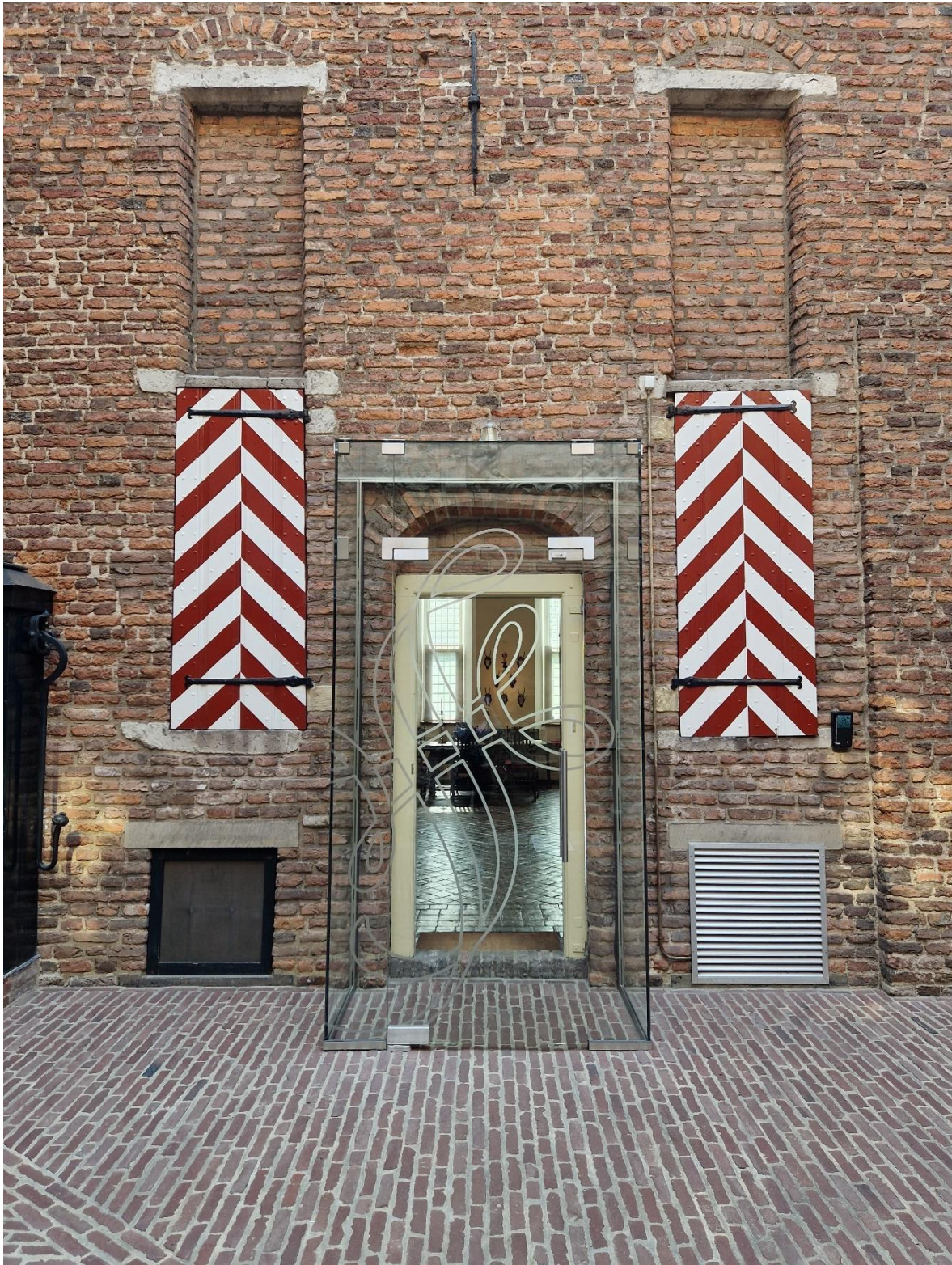
Figuur 12. Binnenplaats, deur naar de entreehal.
