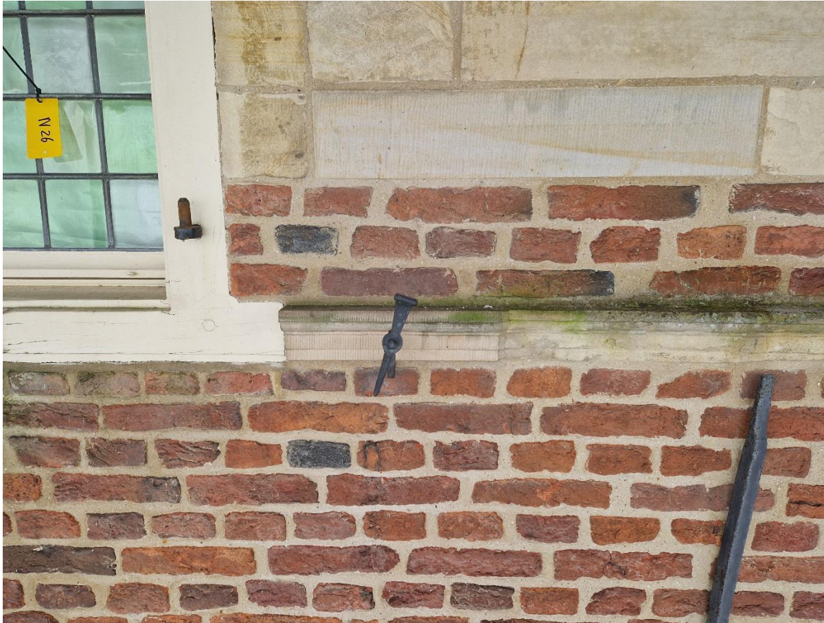
Figuur 72. Detailfoto van een deel van een venster met aansluitend een natuurstenen band. Een deel van die stenen band is vernieuwd (midden) en rechts is het oude natuursteen.
