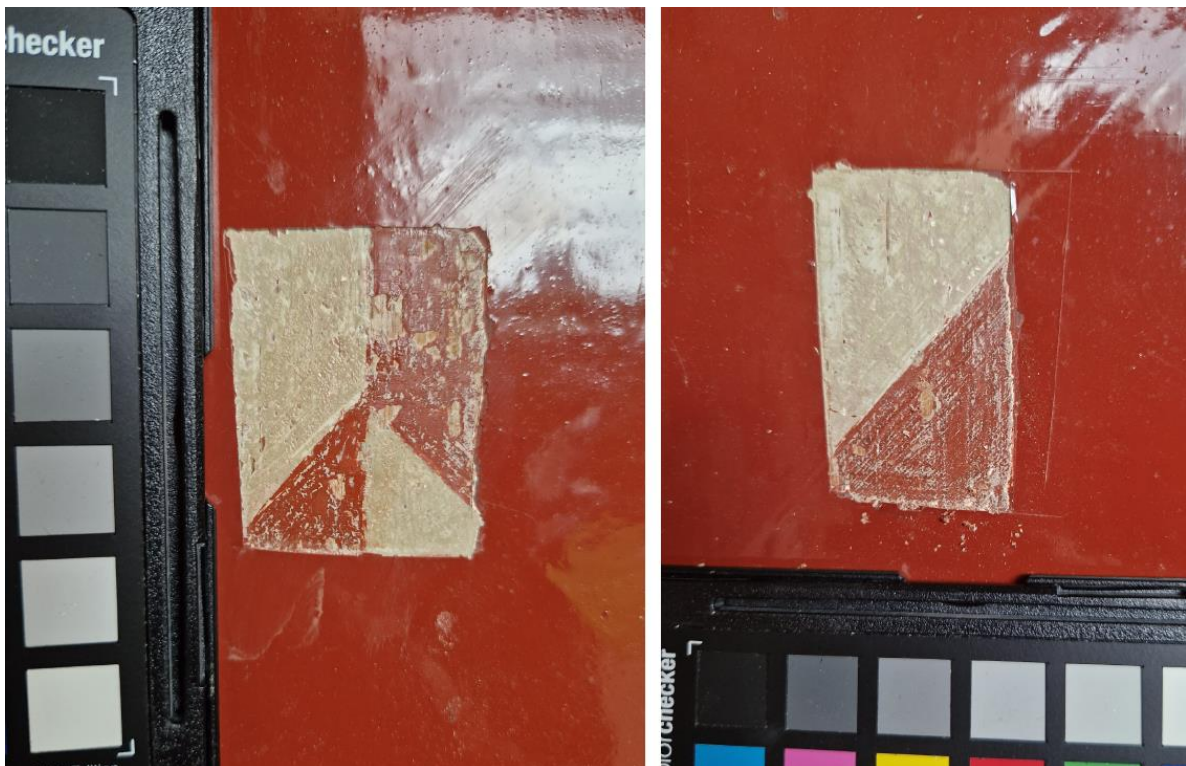
Figuur 37. Twee vensters, vrijgelegd op locatie "Deur 1", zie vorige afbeeldingen. Op deur 1 is net als op de luiken in de binnenplaats van oorsprong kepers aangebracht in altemnerend rood en wit.
