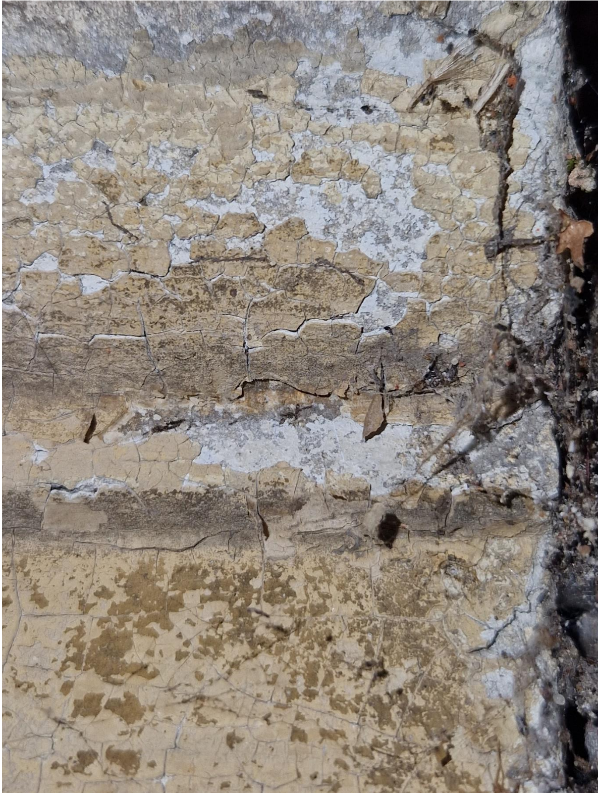
Figuur 71. Detailfoto van het verfpakket dat is aangetroffen op een deel van de natuurstenen band, tegen de grote toren aan.
