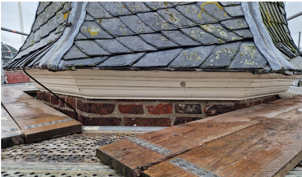
Figuur 74. punctie op de gootlijst van een van de erkertorens.
