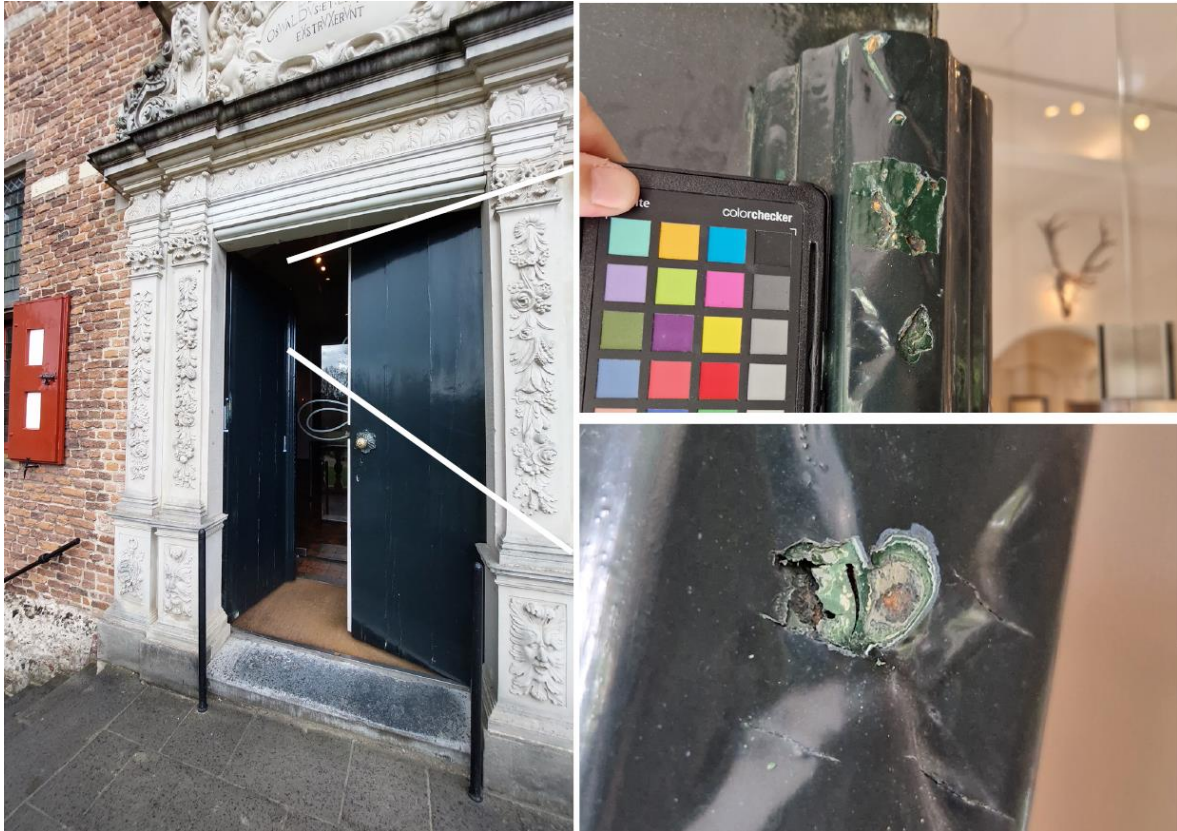
Figuur 64. Puncties op de lijst van de deur ter controle van een kleuraccent op de lijst en in het bijzonder de diamantvormige versiering. In de hoeken zijn nog veel afwerkingen aanwezig, maar geen aanwijzing voor een kleuraccent.
