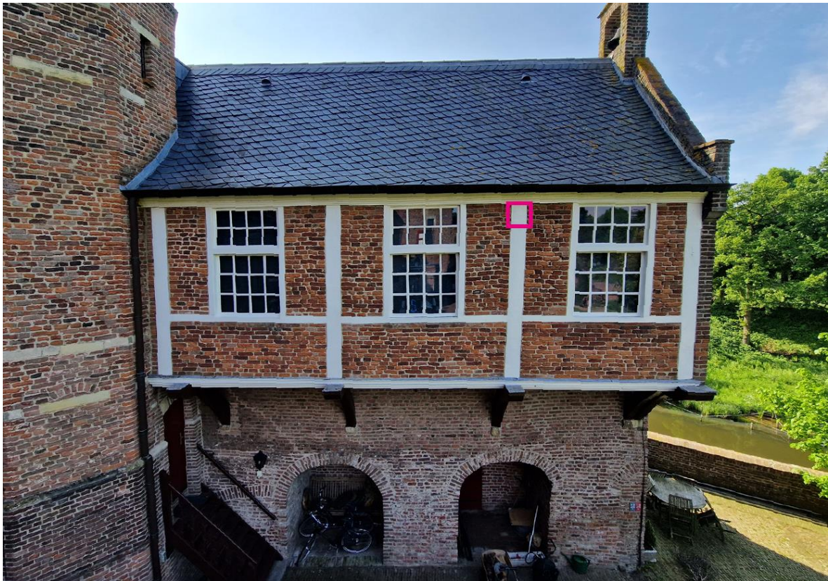
Figuur 42. Noordgevel van de kapel. Locatie van kleurtrap op een van de houten balken van het vakwerk.
