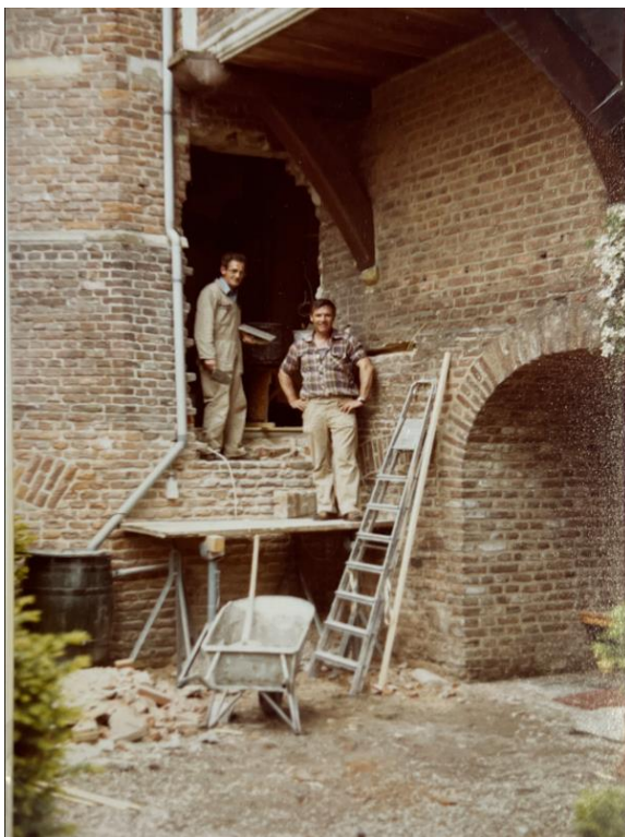
Figuur 9. Gat in de muur van de toren naast de kapel. De deur die er nu zit stamt uit die tijd, net als de trap die erheen leidt. Datering en fotograaf onbekend. Jaren 70? Bron: Archief Huis Bergh.
