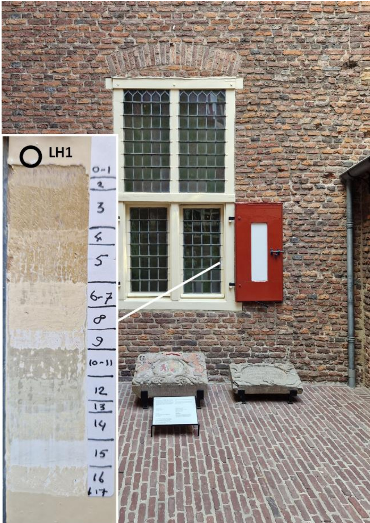
Figuur 16. Kleurtrap op het raamhout in het binnenplaats en locatie van dwarsdoorsnede LH1.
