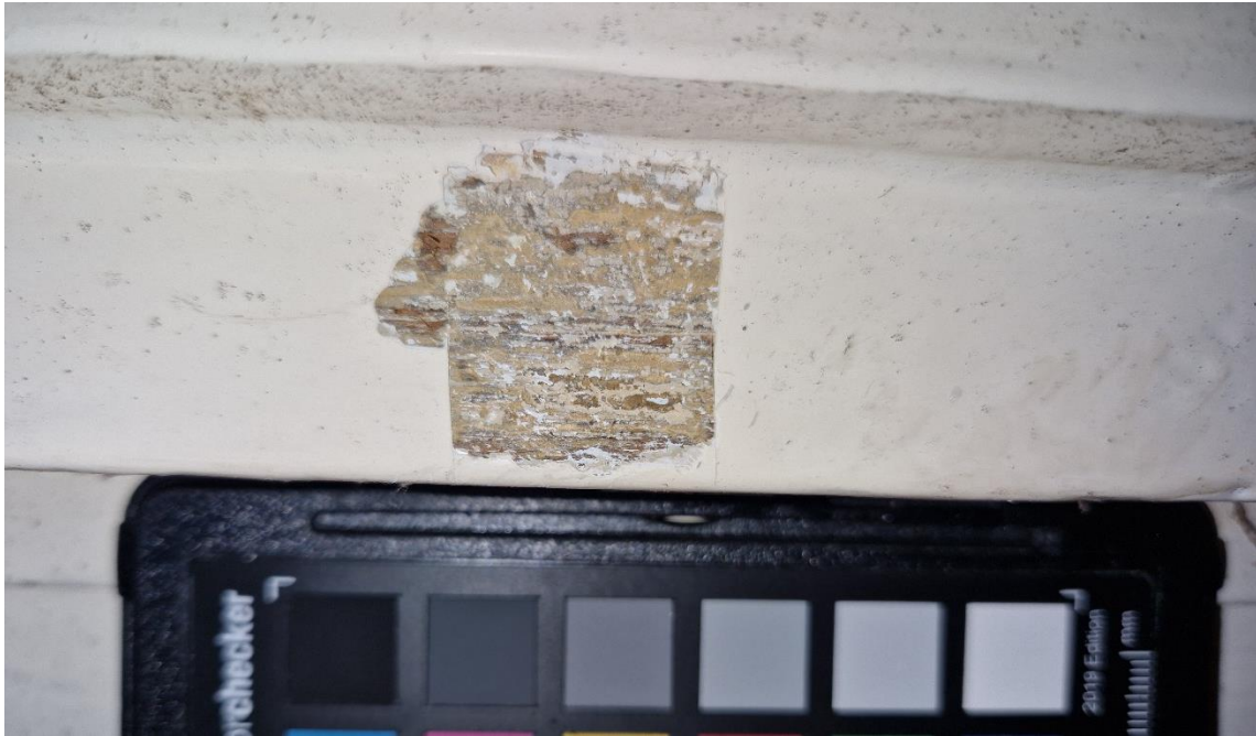
Figuur 75. punctie op de gootlijst van een van de erkertorens.
