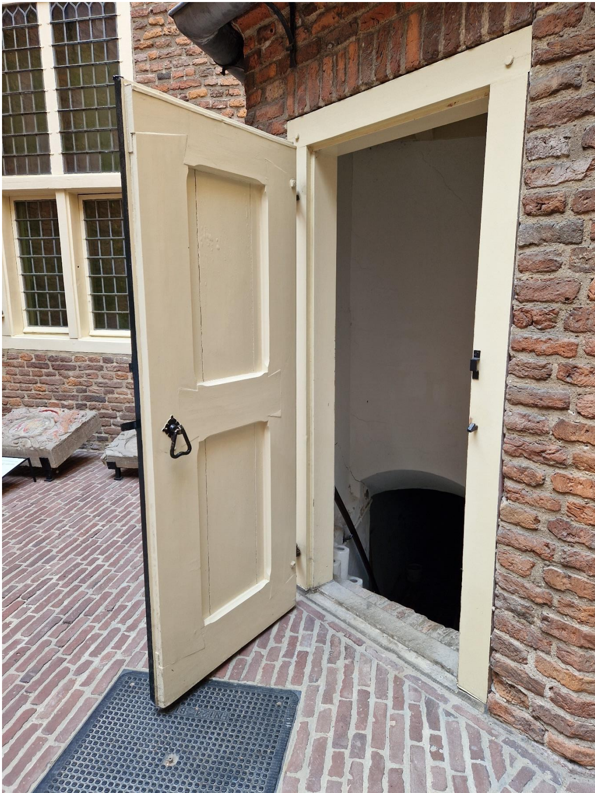
Figuur 15. Binnenplaats, deur naar de kelder.
