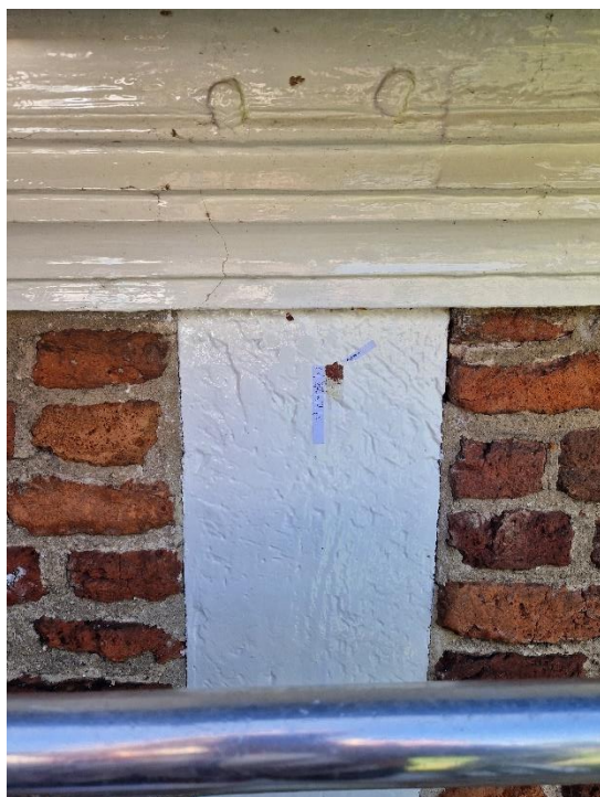
Figuur 43. Kleurtrap op een van de houten balken van het vakwerk van de noordgevel van de kapel. Locatie dwarsdoorsnede Kapelb1.
