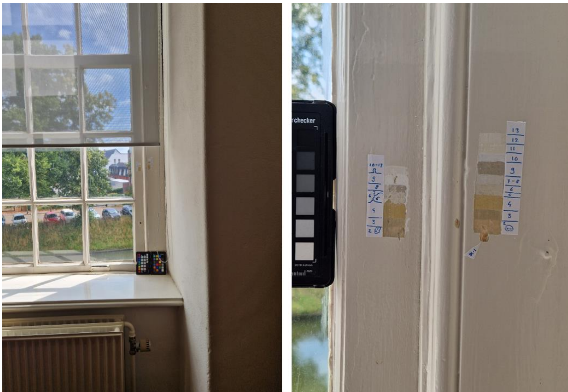
Figuur 32. Twee kleurtrappen op het raam en het raamkozijn in ruimte x. De dwarsdoorsnede IK1 is onder de kleurtrap op het raamkozijn genomen.
