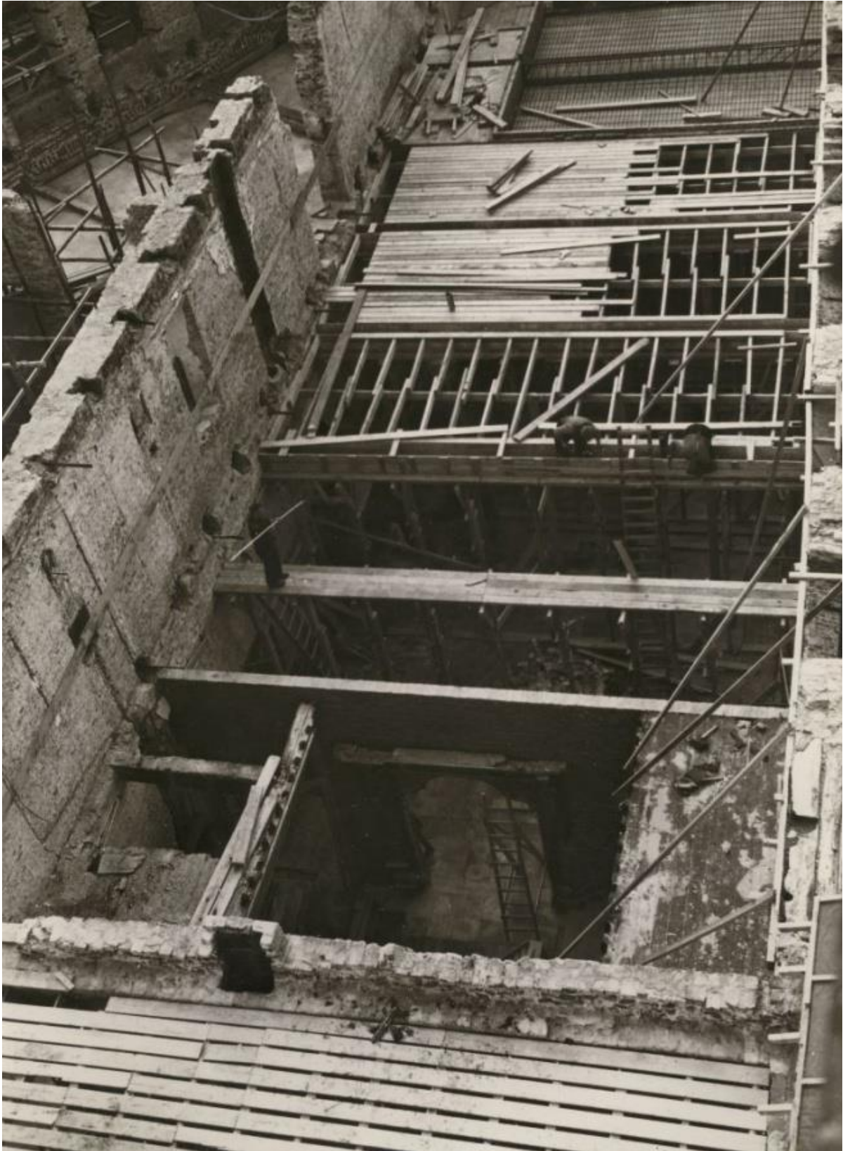
Figuur 17. Zicht van het kasteel van boven na de brand van 1939. Er staat een ladder bij het portaal in de hal op de begane grond. Daarboven is het trappenhuis te zien dat daar nagenoeg leeg is. Bron: https://www.berghapedia.nl/index.php?title=Bestand:Huis_bergh_opbouw_16_kl.jpg
