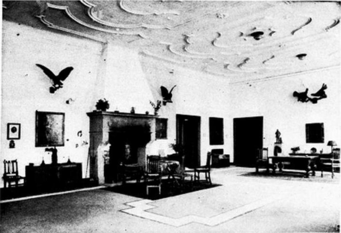
Figuur 7. Een van de zalen voor de brand. Opvallend is het stucplafond die er nu niet meer is. Bron: boek
