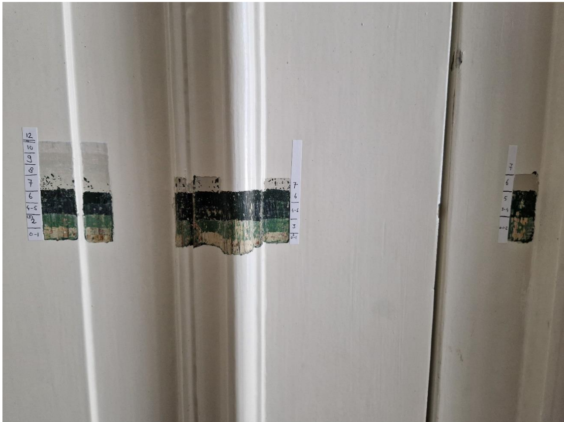
Figuur 41. Foto van alle kleurtrapjes die zijn gemaakt op de deur en het deurkozijn van het kantoor. Alle kleurtrappen zijn gelijk aan elkaar, er lijkt geen sprake te zijn van een variatie in kleur.
