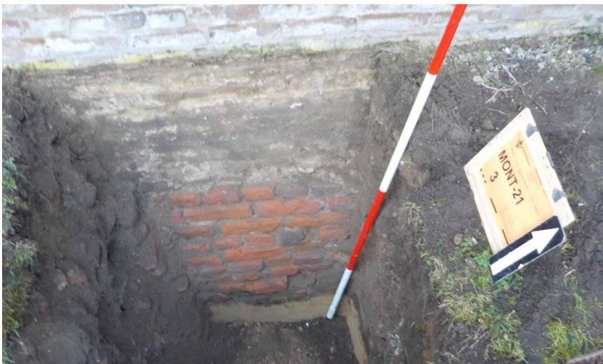
Afb. 8. Fundering op dekzand met onderliggend vlijlaagje in kijkgat 18 (poorthuisje).
