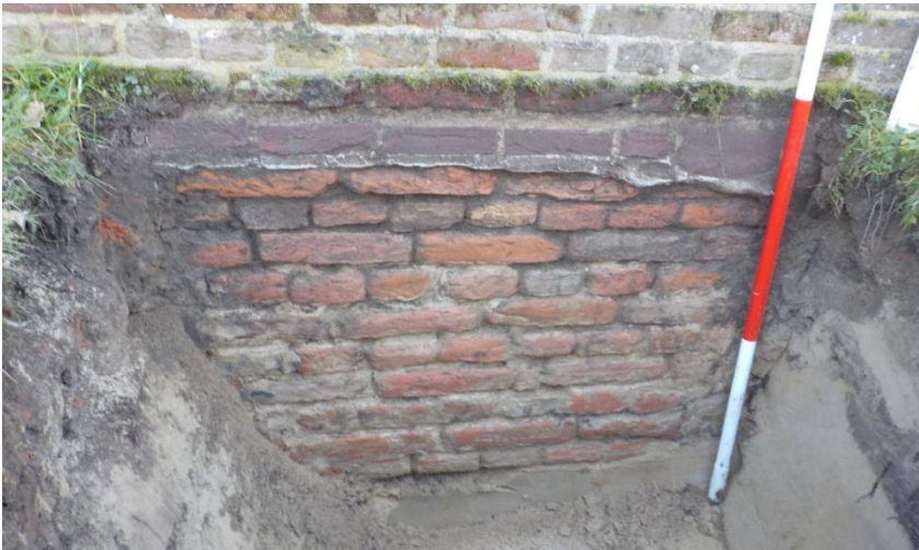
Afb. 7. Fundering op het dekzand in kijkgat 16 (noordmuur voorburcht).
