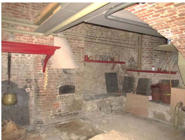
wand zuidzijde in het souterrain
